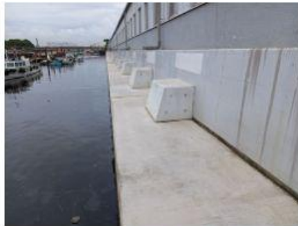
2021 日産自動車横浜工場 陥没補修工事
