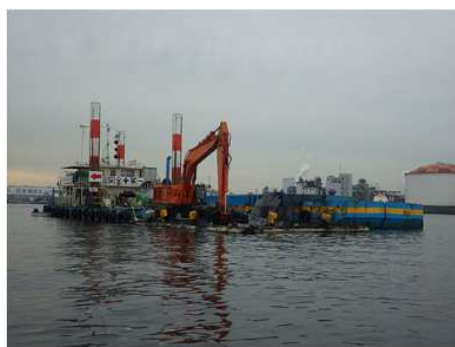
2017 殿町羽田空港線内航路 浚渫工事
