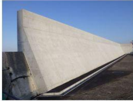
2020 本牧D突堤災害復旧工事・パラペ ット嵩上げ工
