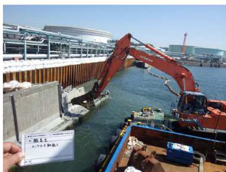
2018 JXTG根岸護岸復旧工事
