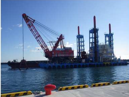
2022 日立港浚渫工事
