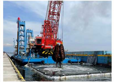
2022 大黒ふ頭岸壁改良工事 (その7)
