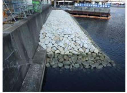
2020 天王洲南運河防潮堤 建設工事
