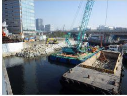
2019 東品川橋架替工事(その3)
