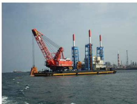
2017 鹿島港外港地区浚渫工事
