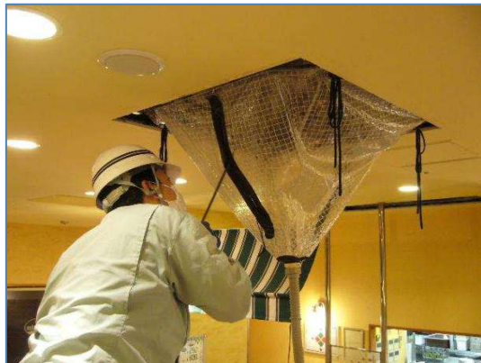
高圧洗浄にて清掃作業中
