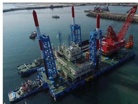
2017 常陸那珂港打継場浚渫工事
