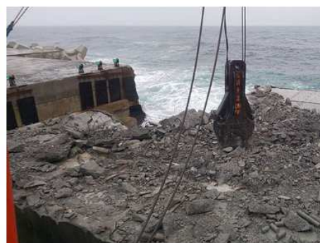
2018 むつ小川原港防波堤 (災害復旧築造)工事
