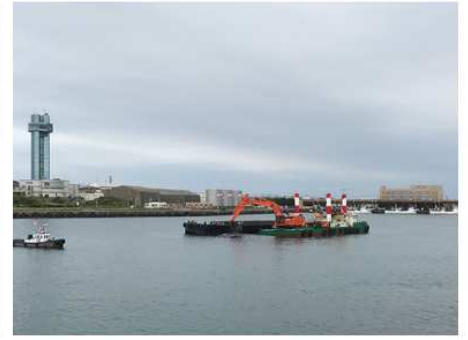
2021 銚子漁港流通基盤整備工事
