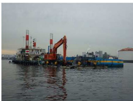
2017 殿町羽田空港線内航路 浚渫工事
