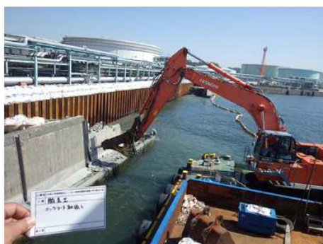
2018 JXTG根岸護岸復旧工事
