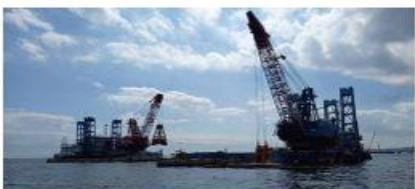
2022 新本牧建設工事 (その22・23)
