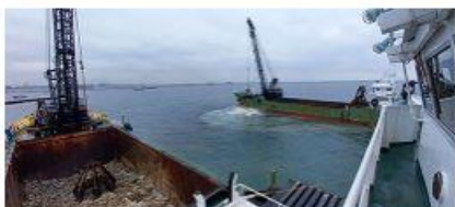
2022 新本牧建設工事 (その22・23)
