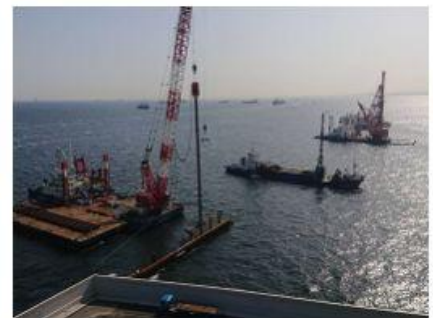
2021 新本牧建設工事 (その10・12・13)
