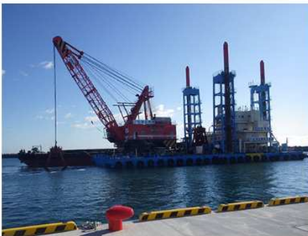
2022 日立港浚渫工事
