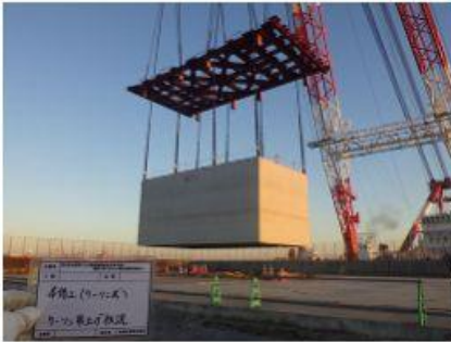
2016 南本牧ふ頭5ブロック 建設工事(その74)
