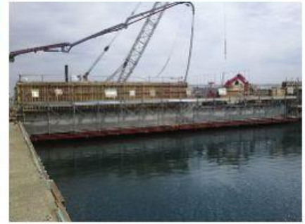
2016 南本牧ふ頭5ブロック 建設工事(その74)
