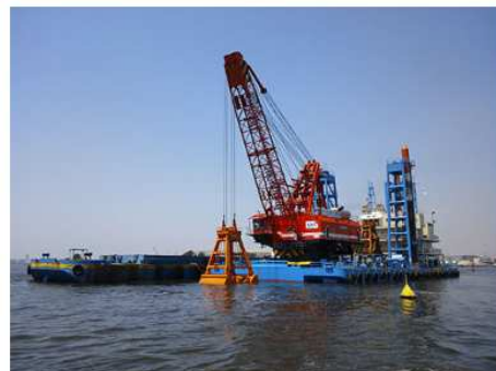
2013 平成25年度市川泊地 浚渫工事
