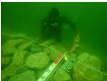
2021 新本牧建設工事(その13)
