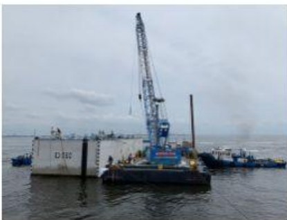
2020 新海面Dブロック 南側護岸建設工事
