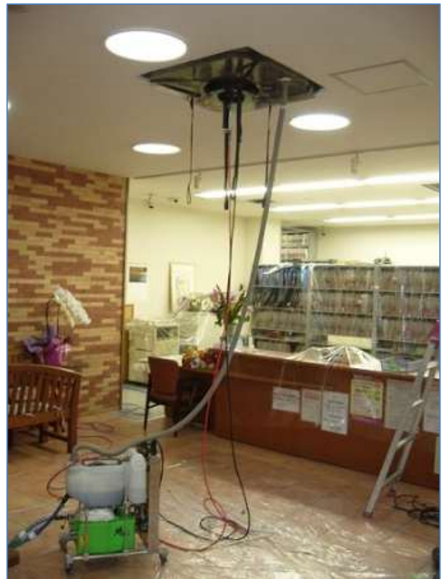
超高圧エアコン洗浄ロボットにて洗浄作業中
