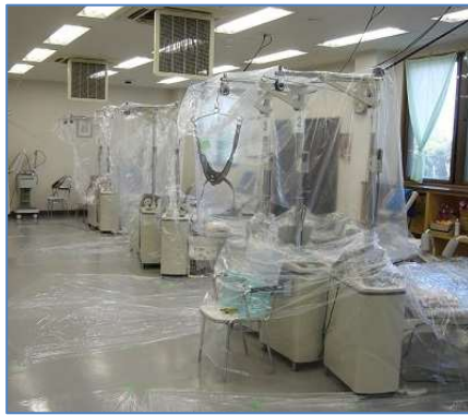
室内養生風景
